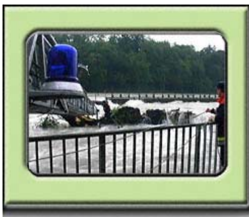
Komplizierte Bergungsarbeiten an der Aarstrasse
